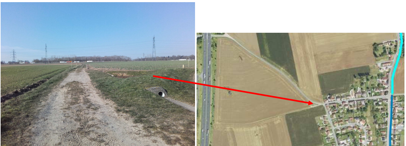
Figure 14 : Photo du bassin de décantation existant – Rue de Flandre
